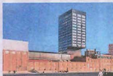
Schwarz und elegant: Das Hochhaus, 70 Meter hoch über der alten Brauerei.
